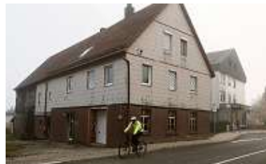
Hier an der Schellbronner Straße sollen elf barrierefreie Wohnungen entstehen.
